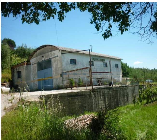
Comparto 2. Edificio in disuso
