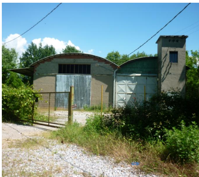
Foto prospetto sud
