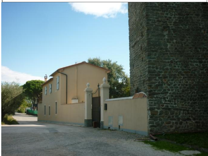
Comparto 3. Edificio residenziale prospetto nord
