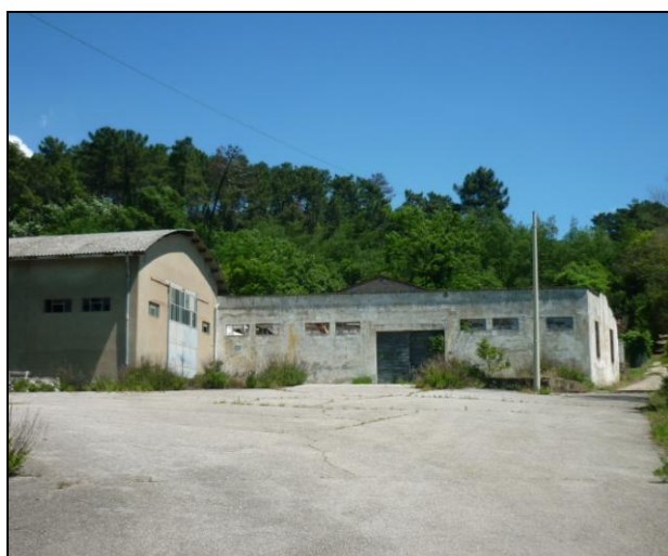
Comparto 1. Edifici presenti. In disuso
