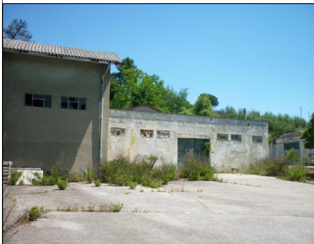
Comparto 1. Edifici presenti. In disuso
