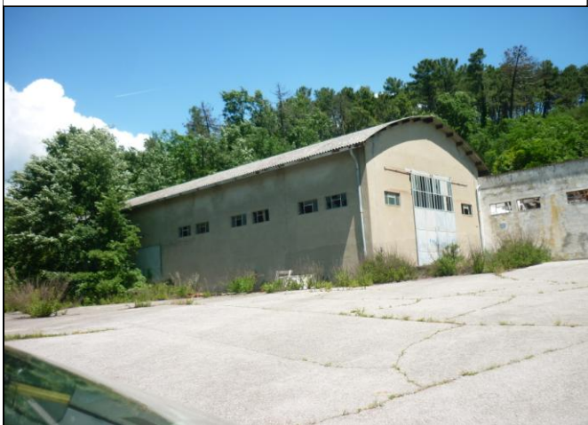
Comparto 1. Edifici presenti. In disuso
